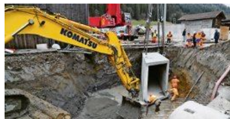
Das erste Wasserführungselement an seinem Platz.
